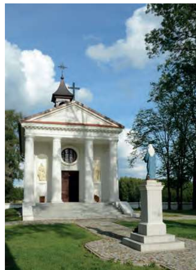
Kaplica w Kolonii Komarno / The Chapel in Kolonia Komarno
