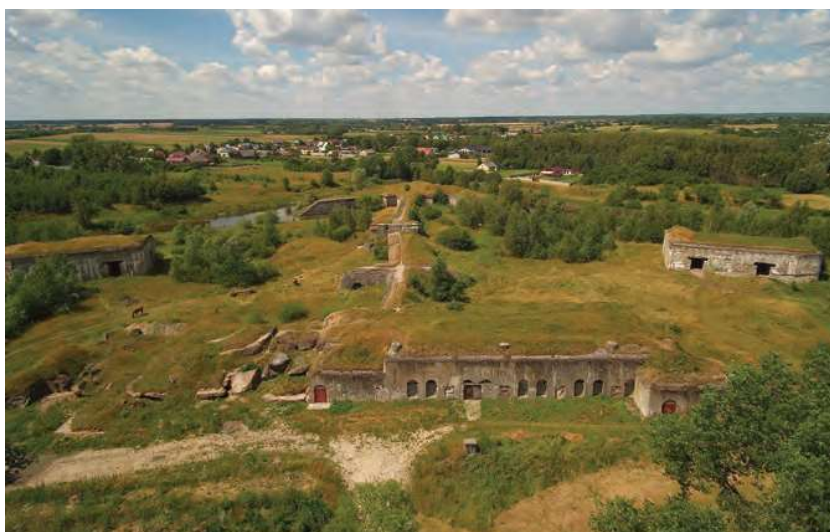
Zespół fortów we wsi Łobaczew Mały / The complex of forts in the village of Łobaczew Mały
