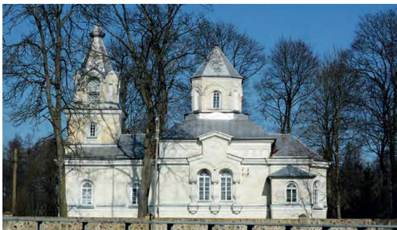
Kościół pw. św. Antoniego Padewskiego w Gnojniu / The Church dedicated to St. Antoni Padewski in Gnojno
