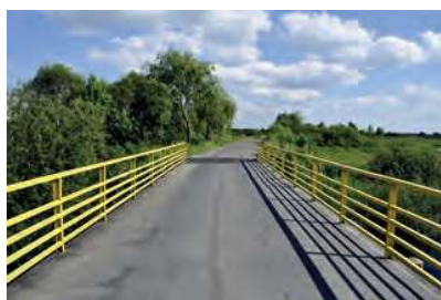
Nowosiółki – most na rzece Krzna / Nowosiółki – the bridge on the Krzna River
