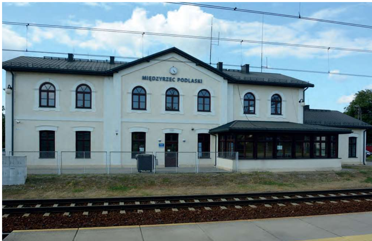
Międzyrzec Podlaski – dworzec kolejowy wzniesiony ok. 1867 r. / Międzyrzec Podlaski – the railway station built around 1867
